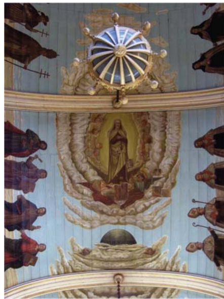
Figura 1: Detalhe da parte central do forro da Igreja da Ordem Terceira do Carmo de São Paulo, com os arcos segmentadores e a imagem da Virgem deslocada, antes do restauro de 2008. Foto: Eduardo Murayama
