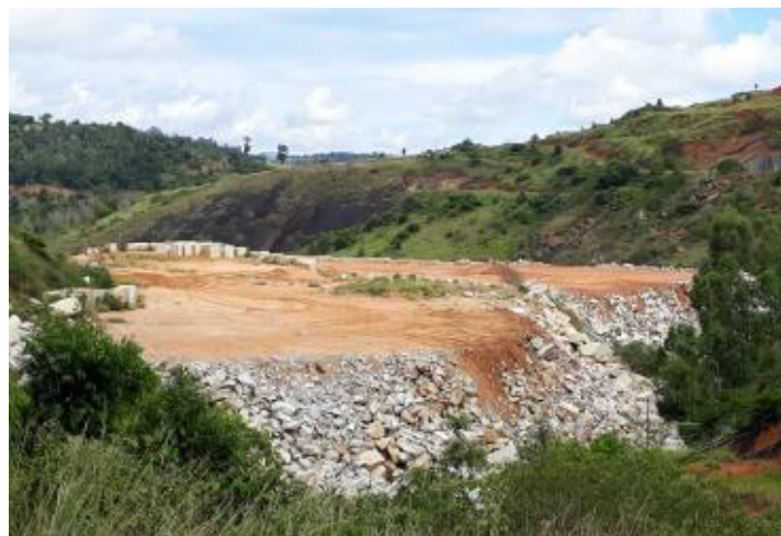
Figura 13: Disposição de estéreis em pilhas (início do projeto)
