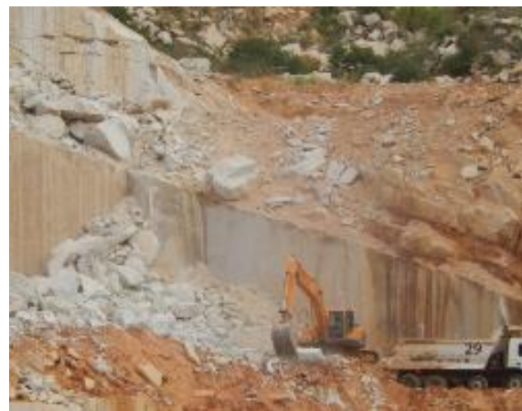
Figura 10: Operações de movimentação de estéril objetivando o desenvolvimento da mina
