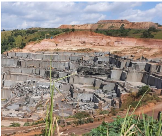
Figura 11: Detalhe de uma mina de RO's sendo verificado a montante uma pilha de estéril
