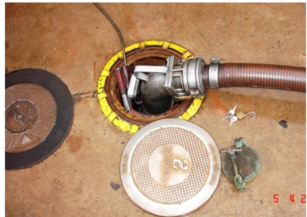
Fonte: Elaborado pelo autor Figura 7. Descarregamento com descarga selada.
