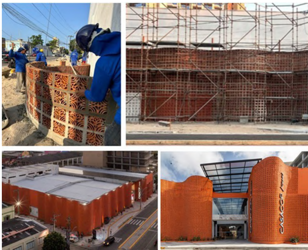
Figura 13: Construção da fachada da CASACOR Ceará 2024 e resultado final.
