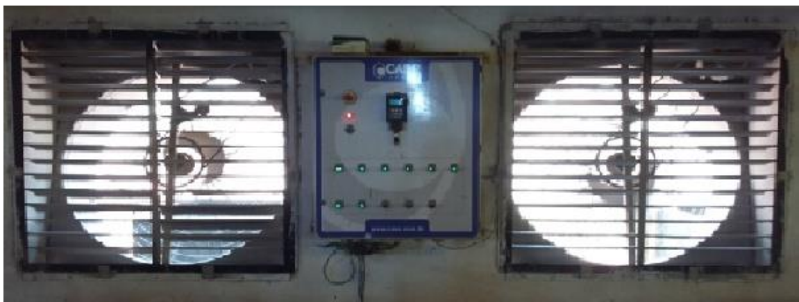
Figura 4 - Exaustores e controlador automático de acionamento. Fonte: Leite (2019)
