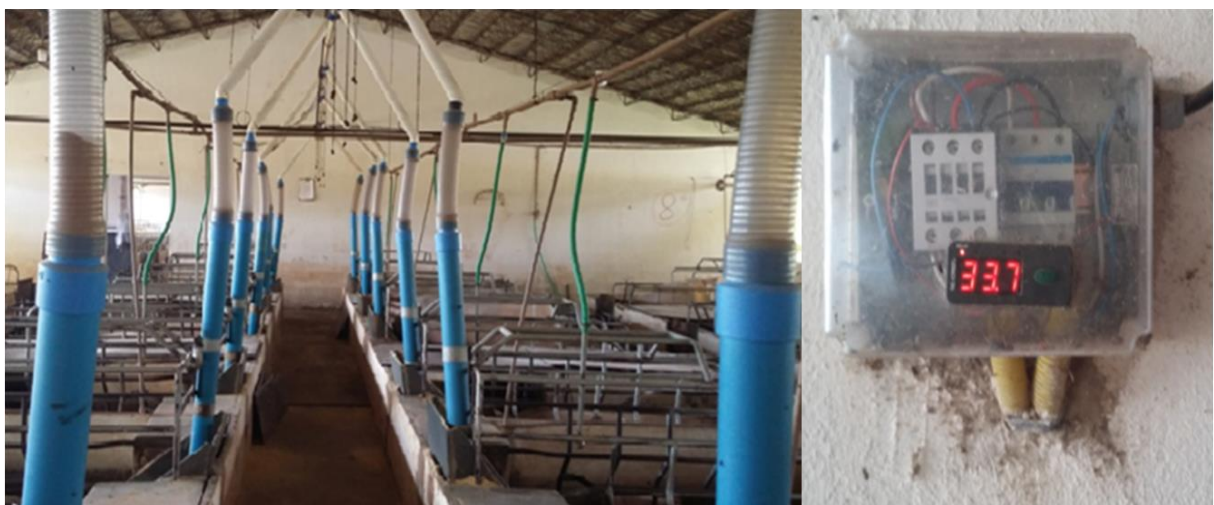
Figura 2 - Galpão convencional sem sistema de climatização e painel automatizado para controle de temperatura dos escamoteadores. Fonte: Leite (2019)
