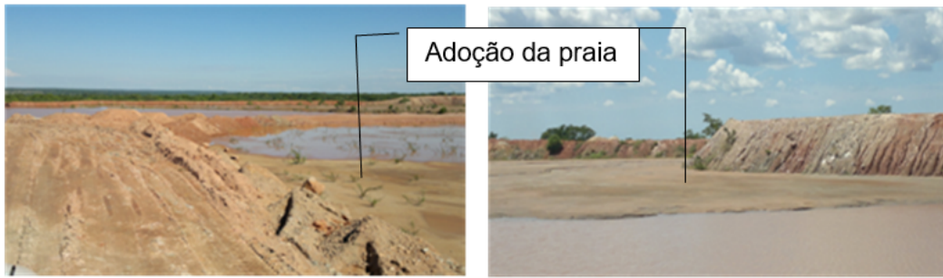
Figura 9 – “Praias” de proteção dos taludes. Fonte: Próprio Autor (2017).
