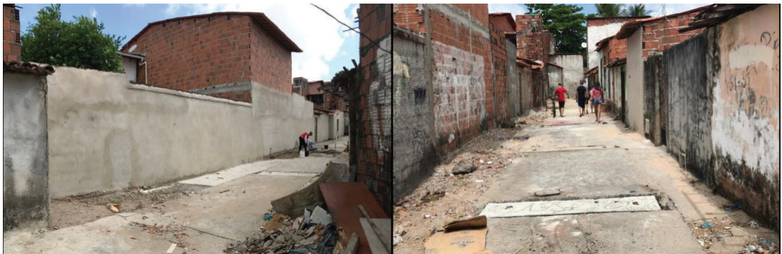
Figura 2: Beco Céu antes do processo de revitalização. Fonte: Instituto Pensando Bem, (2024).
