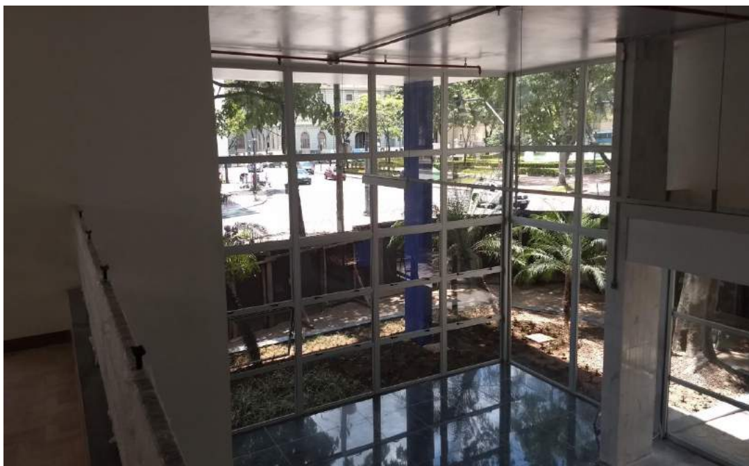
Figura 2 - Fotografia interna do saguão onde se instalaria o espaço cultural antes da finalização da obra.
