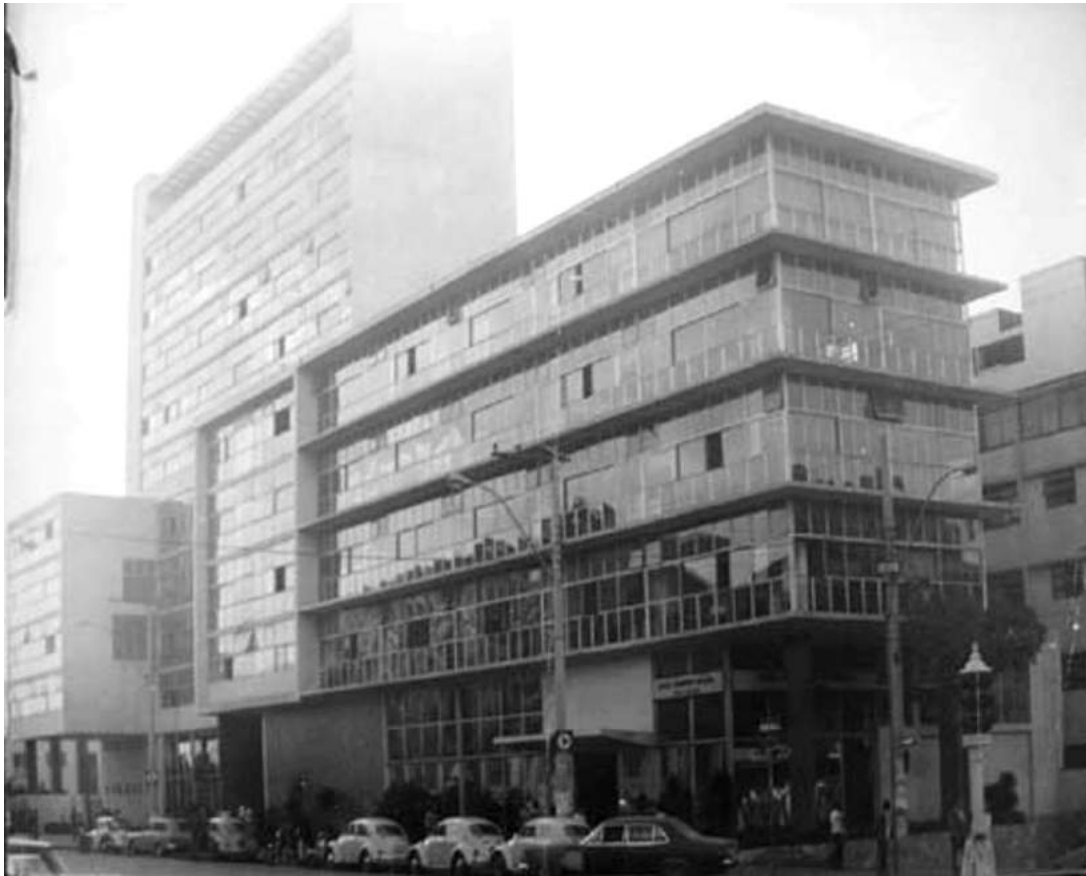
Figura 1 - Fachada do prédio do IPSEMG voltada para a Rua Gonçalves Dias no final da década de 1970, antes do plantio das árvores.
