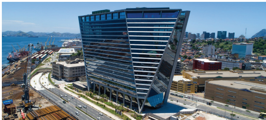
Figura 2 – Vista do Aqwa Corporate, um dos edifícios corporativos triple A da região. Fonte: Site da RAF Arquitetura, desenvolvedora do projeto em parceria com Foster and Partners e Norman Foster, autores do projeto. Disponível em: https://rafarquitetura.com.br/projetos/aqwa/ . Acesso em: 28 mar. 2026.
