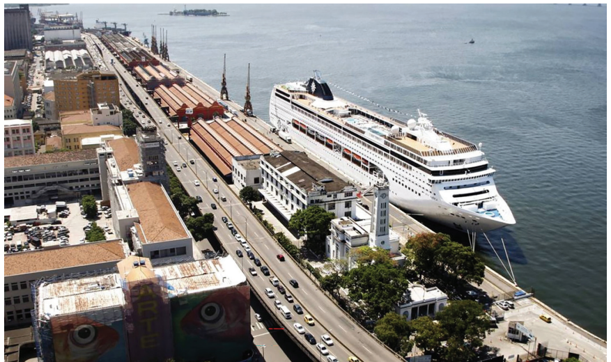
Figura 1 – Vista do elevado da Perimetral, que cerceava a aproximação da malha urbana da Baía de Guanabara. Fonte: Marinho, Simone. Viaduto da Perimetral. O GLOBO, Rio de Janeiro, 16/10/2013. Disponível em: https://oglobo.globo.com/rio/perimetral-para-nao-ser-esquecida-10394243 . Acesso em: 28 mar. 2026.
